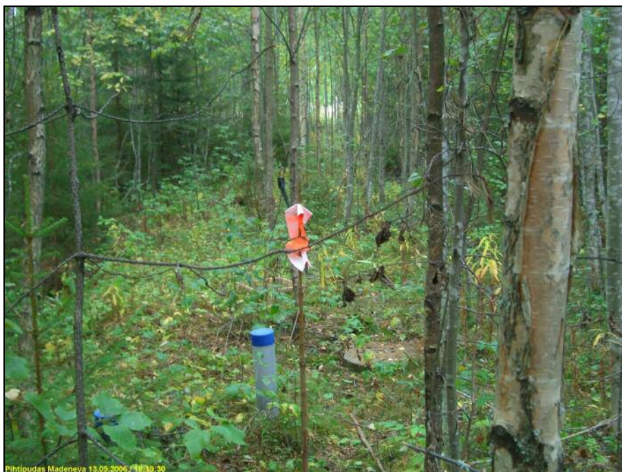
Maastoa alueen kaakkoiskulmassa, missä MP-törmän päällä on pohjavesikaivo ja vesijohtolinja, joka on peittänyt ja särkenyt alkuperäisen maaston. Kuvattu radan suuntaan.
